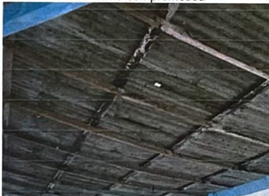
Figura 2 – Cobertura com diversas telhas danificadas e estrutura comprometida
