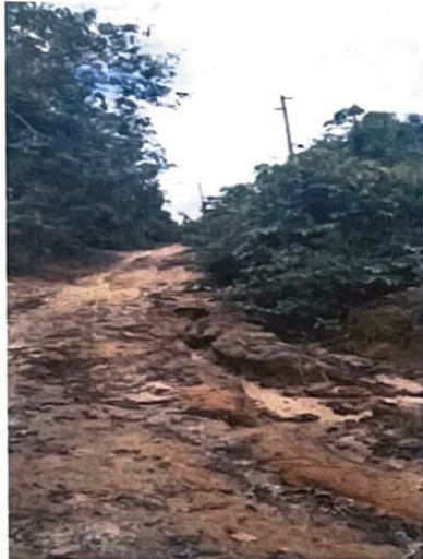
Figura 1 – Trecho do ramal apresentando erosão.
