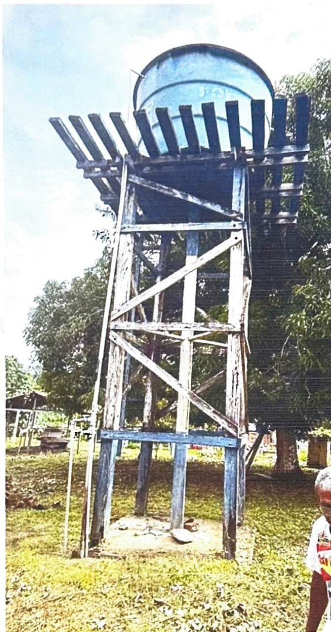
Figura 1: Vista da base de madeira com sinais de apodrecimento e inclinação estrutural
