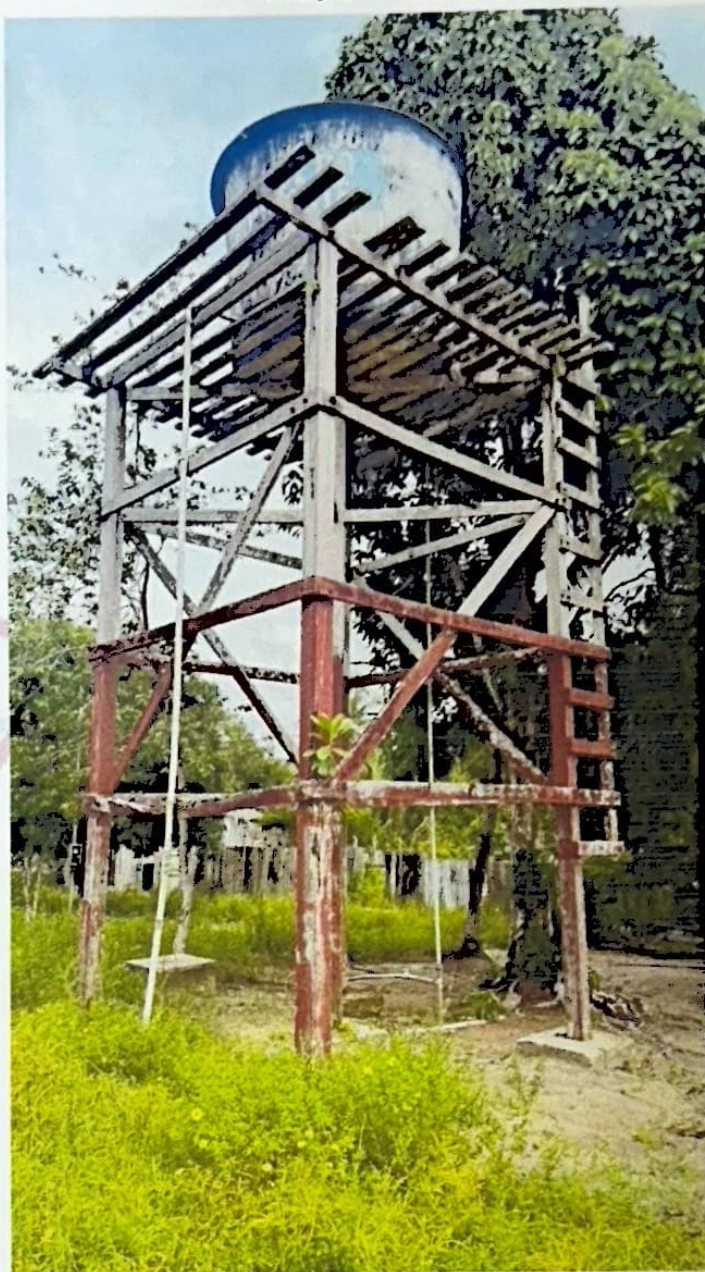
Figura 2: Detalhe do segundo microssistema, demonstrando a fadiga do material de sustentação.
